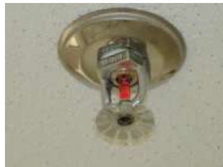
Figura 45 – Chuveiro automático
