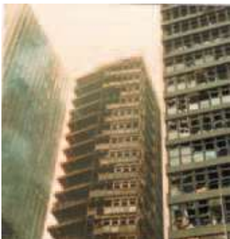
Figura 7 – Radiação de calor de um edifício para outro
